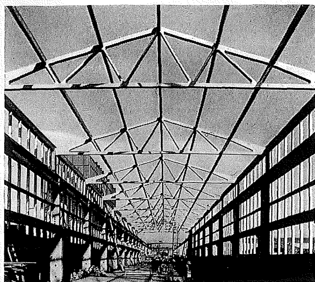
Standardgitterspær af chokbeton til industribyghaller.
