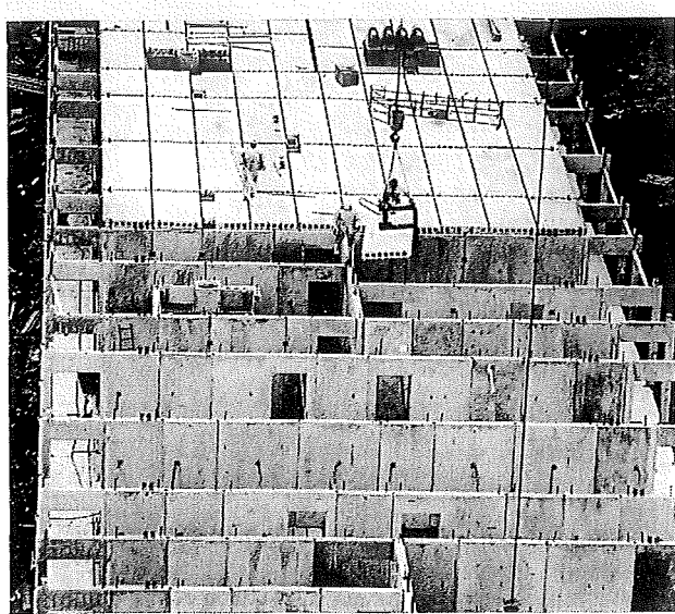
Standardelementer i modulære formater kan benyttes i alt boligbyggeri projekteret efter modulordningen.
